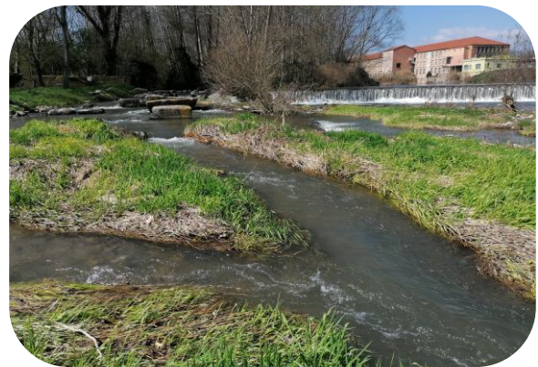
Rampa per a peixos de la resclosa de la Teula (Manlleu)
