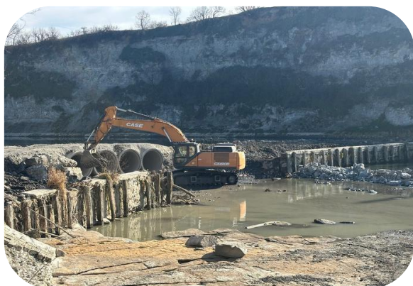
Obres d'eliminació de resclosa del riu Ter a can Buxó (Manlleu)
