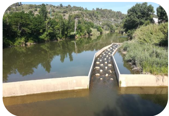
Rampa per a peixos a la resclosa de Món Sant Benet (Sant Fruitós de Bages)
