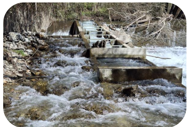
Dispositiu de pas de peixos de safareigs successius a la resclosa de Borgonyà
