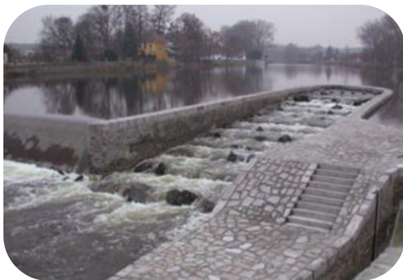
Rampa per a peixos al riu Dye (República Txeca)
