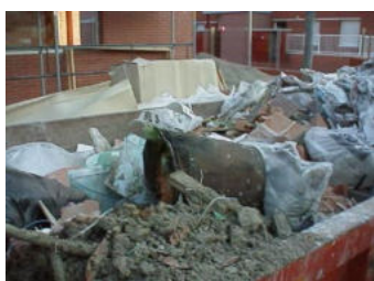
Imatge contenidor obra sense separació selectiva. Font: coac.net
