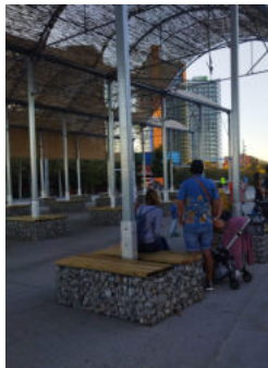
Per llast amb elements pesants com els gabions Font: BATEC
