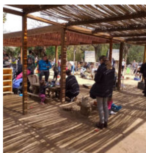
Estructura fusta i cobertura de canya. Laludo, espai lúdic al Parc de la Ciutadella. Font: TALHER
