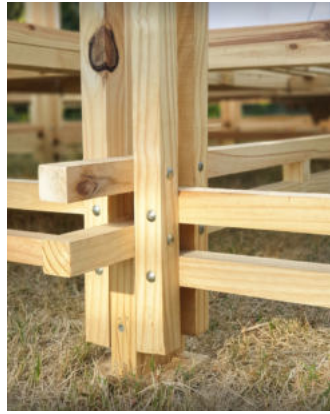
Estructura de fusta amb unions cargolades. Font: architizer.com
