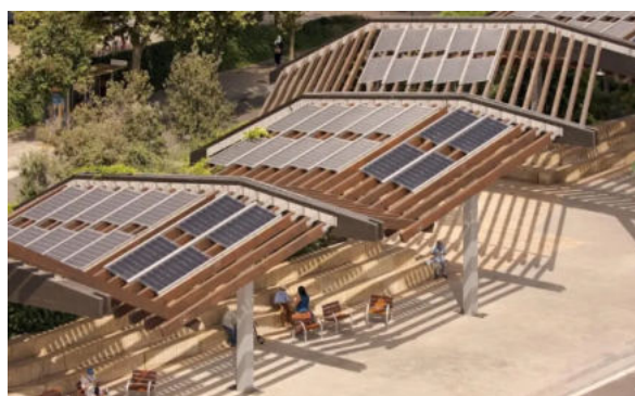
Exemple reaprofitament de pèrgola per fotovoltaica sobre la Ronda de Dalt de la Vall d'Hebron
