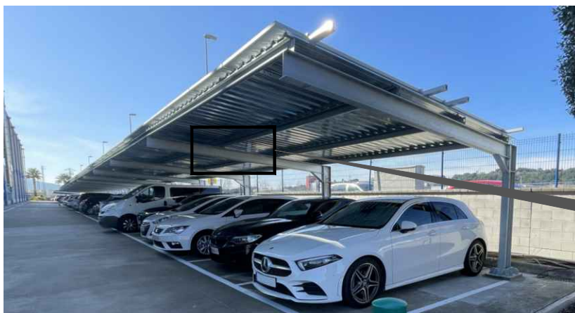
DETALLE ESTRUCTURA INSTALADA
