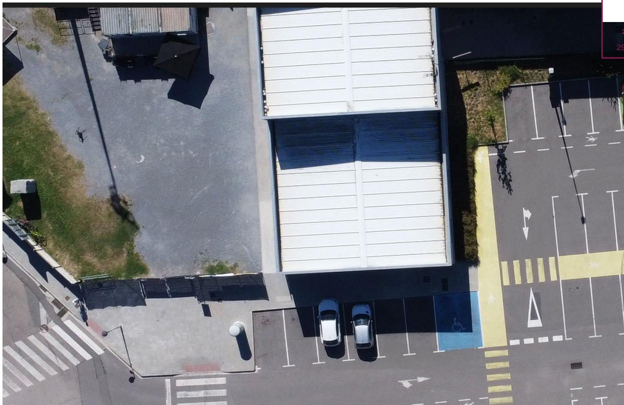
Imatge 3. Vista aèria general traçat canalització
