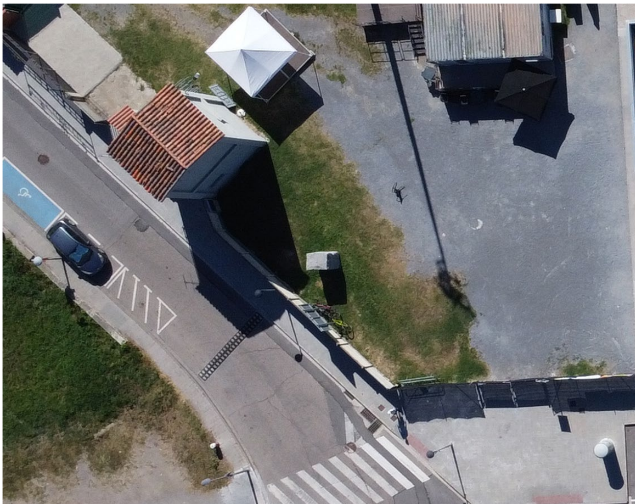
Imatge 2. Vista aèria general escomesa
