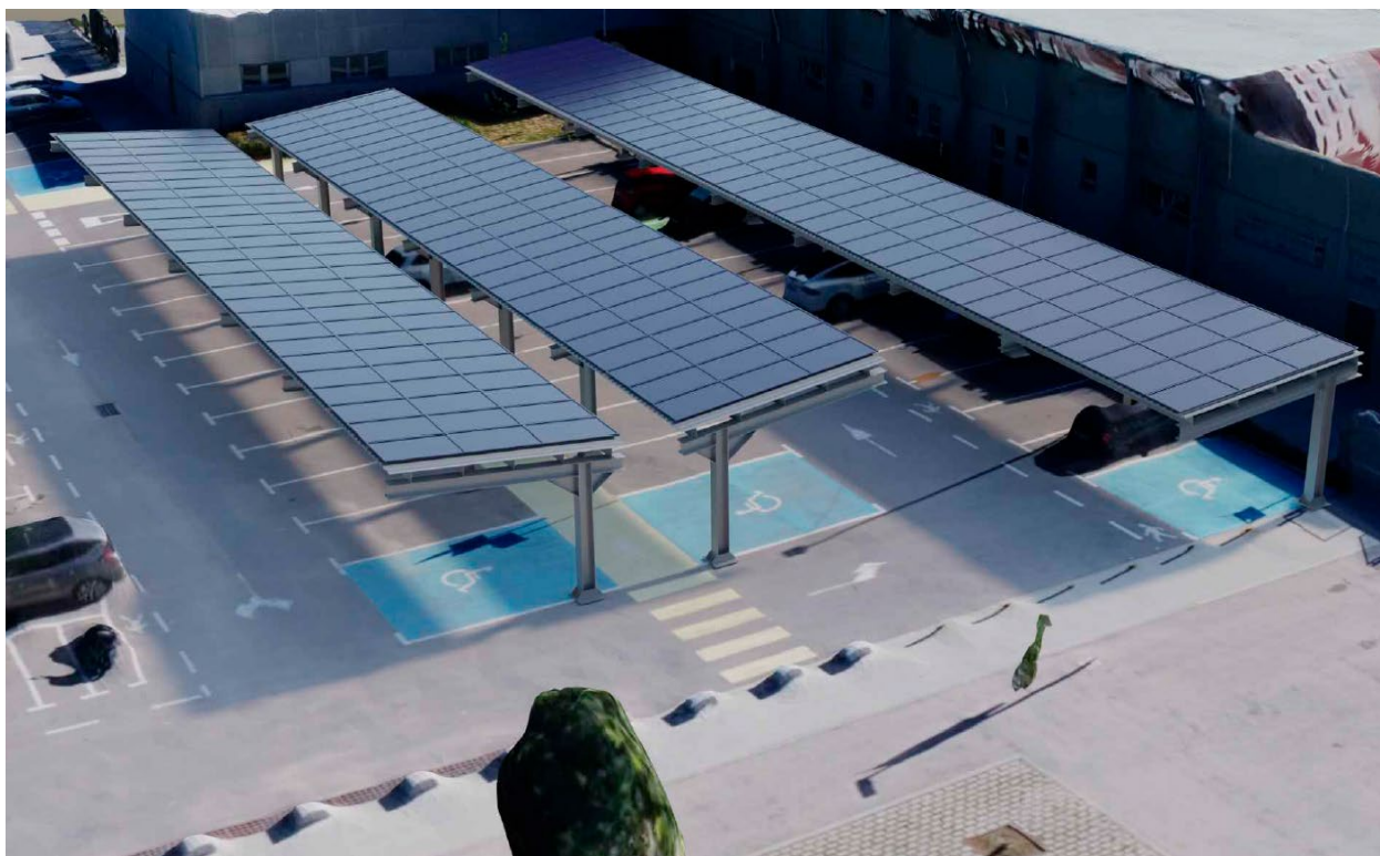
Imatge 14. Simulació pèrgola fotovoltaica en l'aparcament
