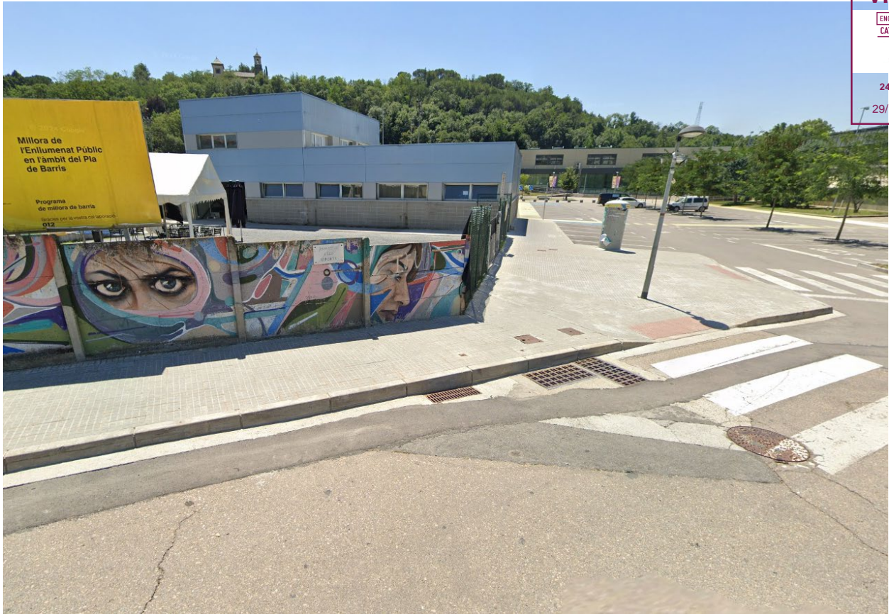
Imatge 9. Vista a nivell carrer de la nova canalització soterrada
