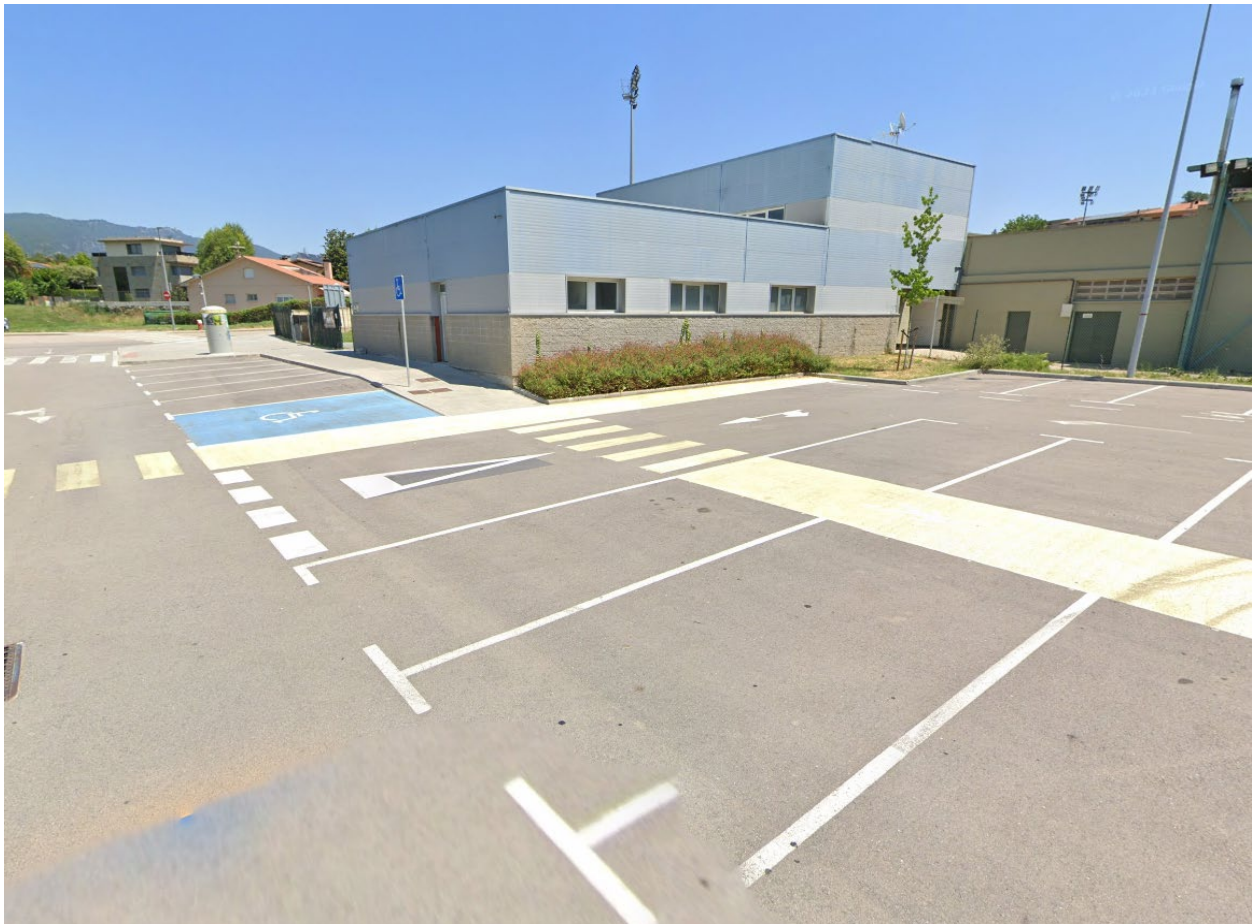
Imatge 10. Vista a nivell carrer de la nova canalització soterrada/subquadre pdr/pèrgoles
