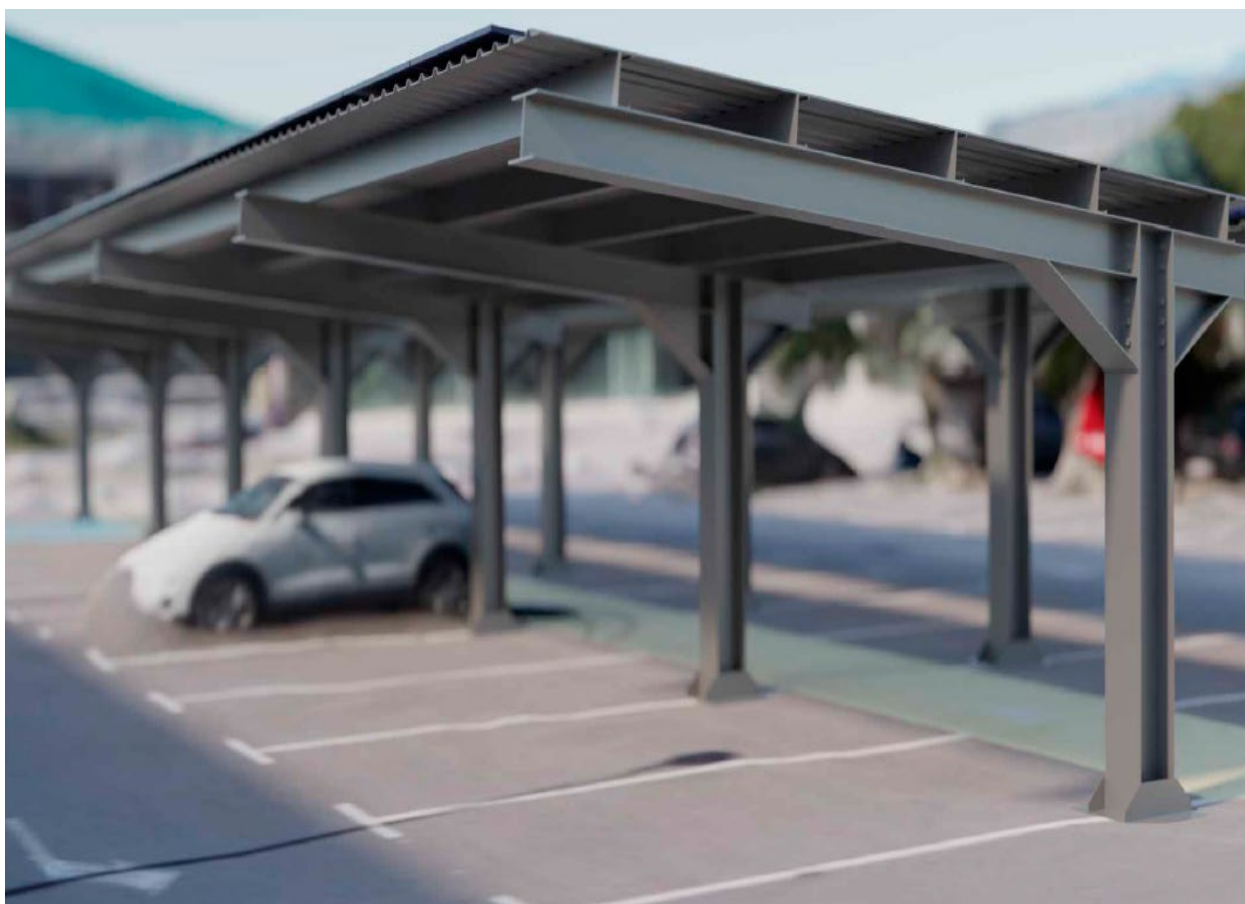
Imatge 16. Simulació pèrgola fotovoltaica en l'aparcament
