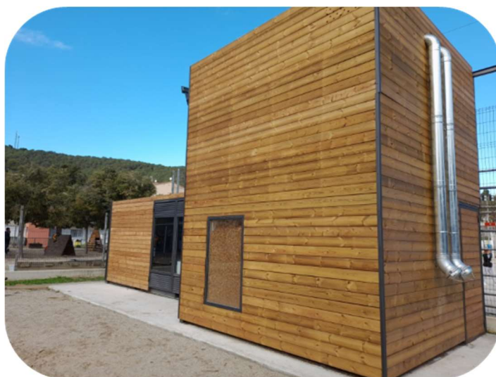
Caldera de biomassa zona escolar a Olivella. Font: Quatre Passes SCCL
