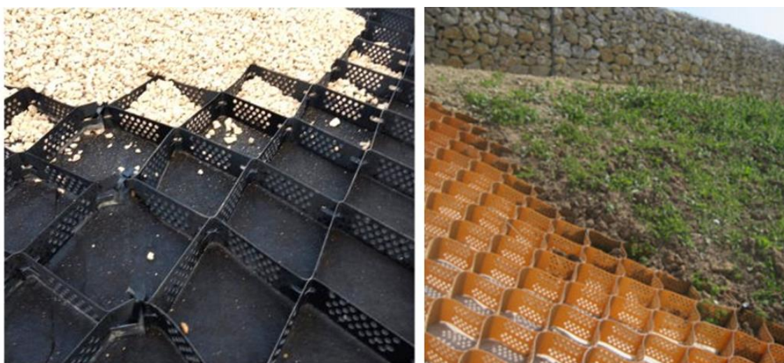
Figura 10. Geocel·les de recobriment dels talussos de la bassa, reblertes amb graveta i amb terra. Aquesta última permet el creixement de vegetació herbàcia, facilitant la sortida per part de la fauna (Fotos: G&C i Projar).
