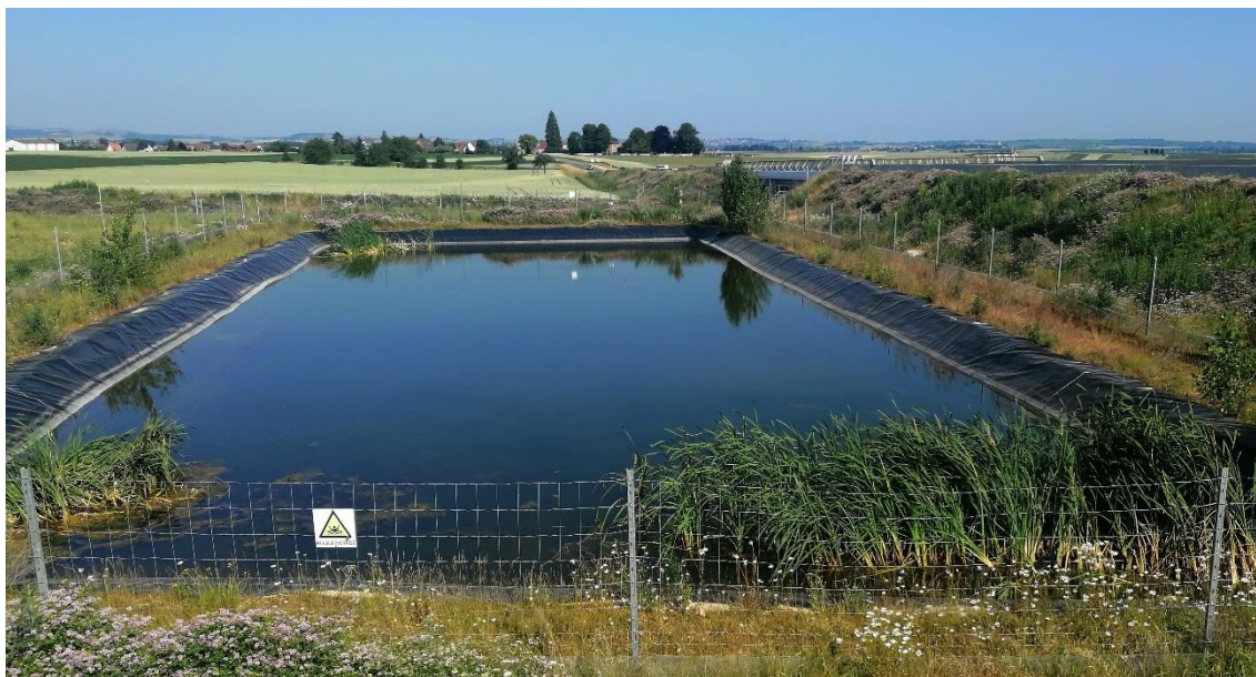
Figura 1. Bassa d'acumulació d'aigua recoberta amb geomembrana. Aquest tipus de bassa suposa un risc d'ofegament per a la fauna, ja que la superfície és molt relliscosa i no els permet sortir. En aquest cas la bassa disposa de tancament perimetral, que evita l'accés d'animals de talla mitjana o gran, reduint el risc de mortalitat per caiguda i ofegament (Font: Minuartia).
