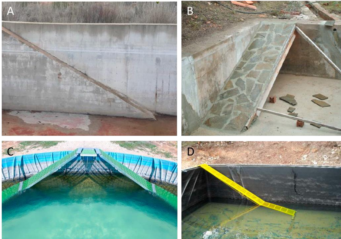
Figura 7. Tipus de rampes de sortida instal·lats en dipòsits. Es mostren rampes de formigó (amb interior reblert o buit) i d'altres materials. En alguns cassos són simples i en altres de doble vessant. També es mostren tant rampes en dipòsits metàl·lics com de formigó. Els dissenys B, C i D poden suposar riscos per als mitjans d'extinció durant la càrrega d'aigua, ja que hi ha risc que les mànegues de captació o galledes externes d'immersió es quedin enganxades. A més, els animals poden quedar atrapats sota la rampa, dificultant-los trobar la sortida (Fonts: APAMCV, 2022 (A; C); SERBAL (B); Generalitat de Catalunya, 2018 (D)).
