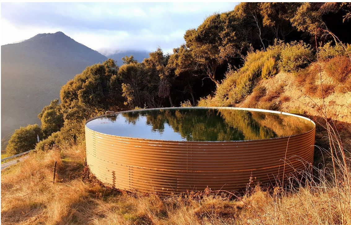
Figura 16. Emplaçament incorrecte d'un dipòsit d'acumulació d'aigua situat a escassa distància d'un talús que permet als animals terrestres accedir al seu interior (Foto: Minuartia).
