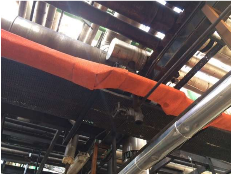
PROTECCIÓ CABLES AMB MANTES
