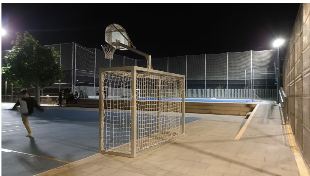
Fotografies d'elaboració pròpia que mostren la manca de barana o element accessible que actui com a límit entre pistes, i el disseny de la rampa de connexió.
