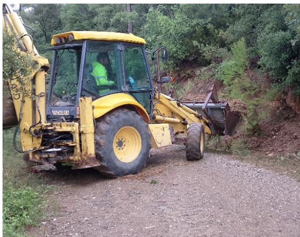
Neteja d'obres de drenatge. Font: Arxiu XPN
