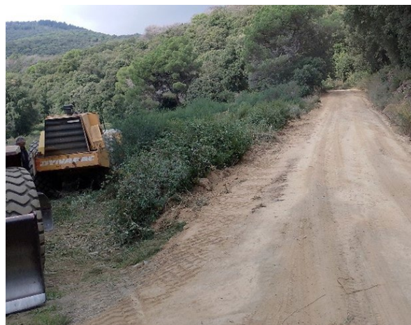
Repàs del ferm i la cuneta. Font: Arxiu XPN
