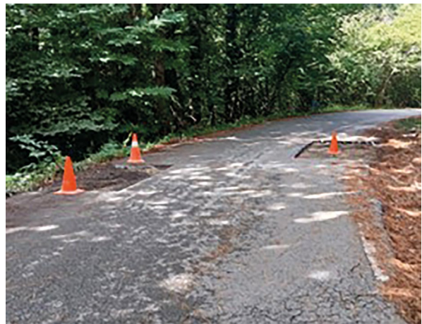
Reparacions en el ferm de la pista de Fontmartina. Font: Arxiu XPN
