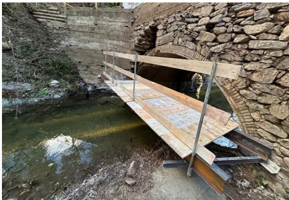
Plataforma per a la reparació de la volta. Font: Arxiu XPN
