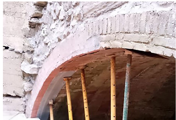
Detall de la reparació. Font: Arxiu XPN
