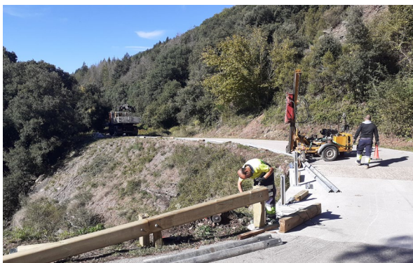
Col·locació de barreres de seguretat al pont del torrent de l'infern i al terraplè. Font: Arxiu XPN
