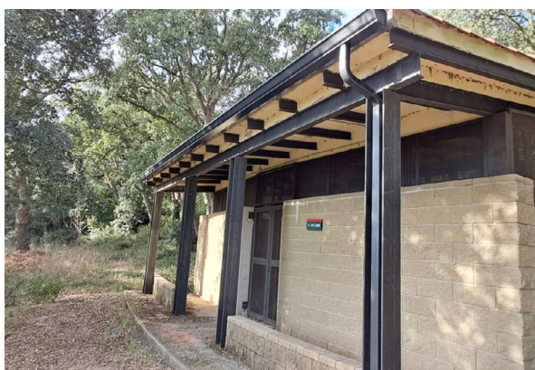
Nova canalització del mòdul de lavabos del campament juvenil el Solell del Corredor. Font: Arxiu XPN
