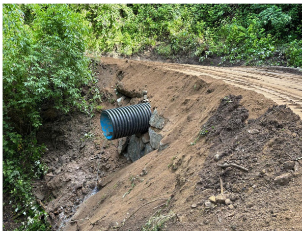
Reparació del tub de pas d'aigua del camí de Can Preses. Font: Arxiu XPN
