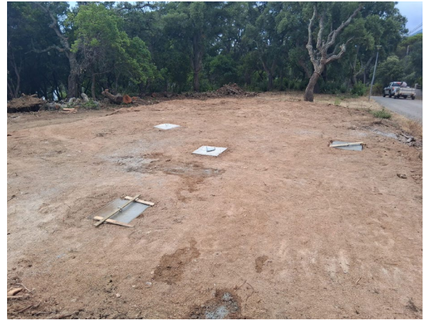
Preparació dels suports per la nova instal·lació de l'estació meteorològica de Collsacreu. Font: Arxiu XPN
