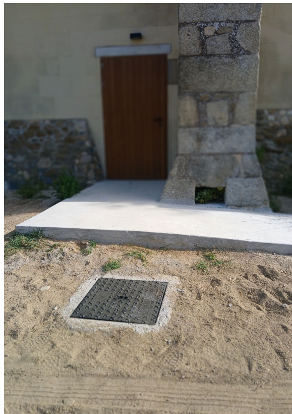
Arqueta de la canalització d'aigua a Can Bosc. Font: Arxiu XPN
