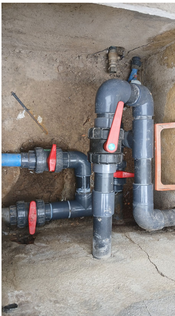
Substitució de canalització al sistema de cloració de l'Àrea d'esplai i el campament juvenil el Solell del Corredor. Font: Arxiu XPN
