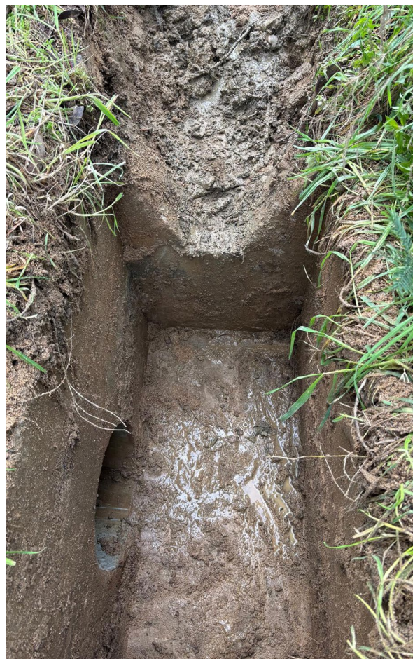
Reparació del tub de pas d'aigua del camí de Can Preses. Font: Arxiu XPN
