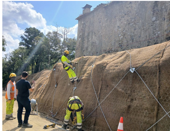
Operaris treballant en l'estabilització del talús de Can Moixer. Font: Arxiu XPN
