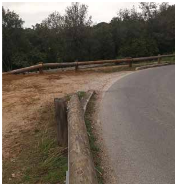
Reparació de la bionda de la pista del Santuari del Corredor. Font: Arxiu XPN
