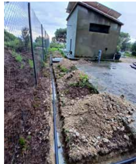
Canvis en el sistema d'alimentació dels dipòsits previstos en el projecte de millora del sistema de cloració de l'àrea d'esplai i el campament juvenil. Font: Arxiu XPN
