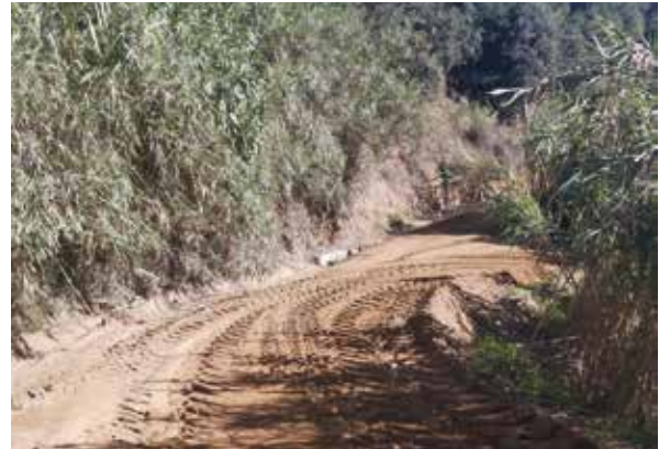
Reparació de la xarxa viària per prevenció d'incendis. Font: Arxiu XPN
