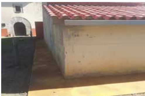
Millores a la teulada de l'edifici annex i s'ha fet la vorera per intentar millorar les humitats d'aquest edifici. Font: Arxiu XPN
