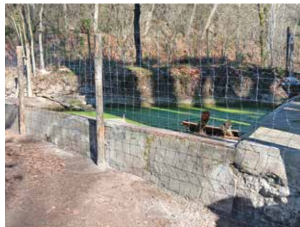
L'altra bassa de Cal Oller després de la reparació d'impermeabilització. Font: Arxiu XPN
