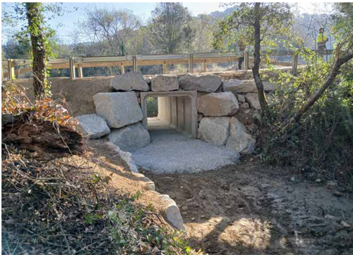
Reparació del pont de Fuirosos. Font: Arxiu XPN
