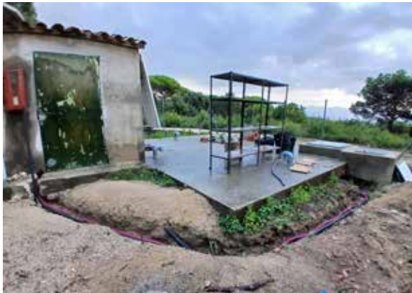
Obres pels canvis del sistema de cloració dels dipòsits. Font: Arxiu XPN
