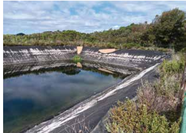
Bassa de prevenció d'incendis de Can Puigdemir, a Vallgorguina. Font: Arxiu XPN
