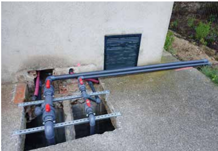
Canvis en el sistema d'alimentació dels dipòsits previstos en el projecte de millora del sistema de cloració de l'àrea d'esplai i el campament juvenil. Font: Arxiu XPN
