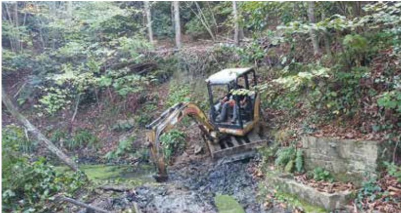
Treballs de maquinària per buscar l'entrada de la mina. Font: Arxiu XPN
