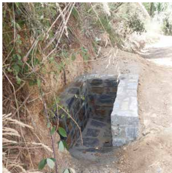
Col·locació d'un pas d'aigua soterrat per la pista de Sobirans. Font: Arxiu XPN
