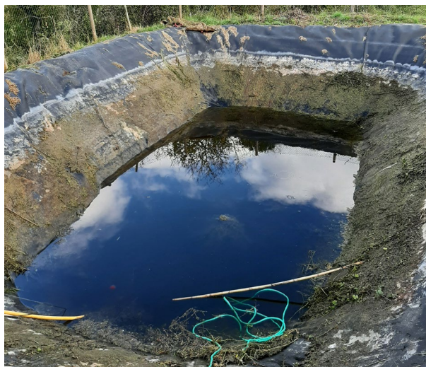
Assecament de la bassa artificial. Font: Arxiu XPN
