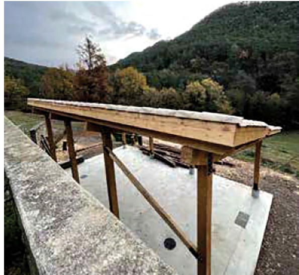
Coberta de la Solana en construcció. Font: Arxiu XPN
