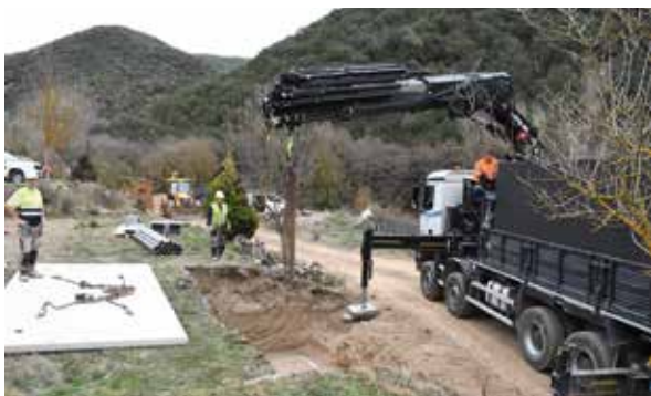
Recollida de pluvials i construcció de dipòsits d'acumulació Casanova Sant Miquel. Font: Arxiu XPN
