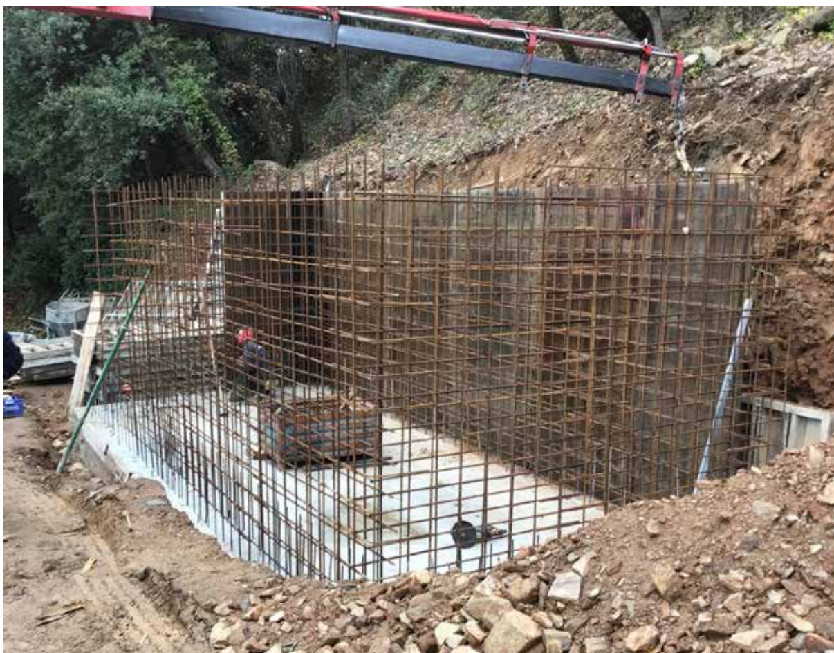
Construcció de l'estructura del dipòsit. Font: Arxiu XPN
