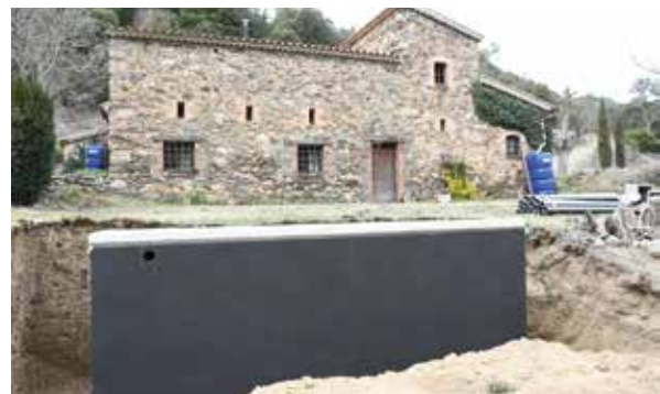
Recollida de pluvials i construcció de dipòsits d'acumulació Casanova Sant Miquel. Font: Arxiu XPN
