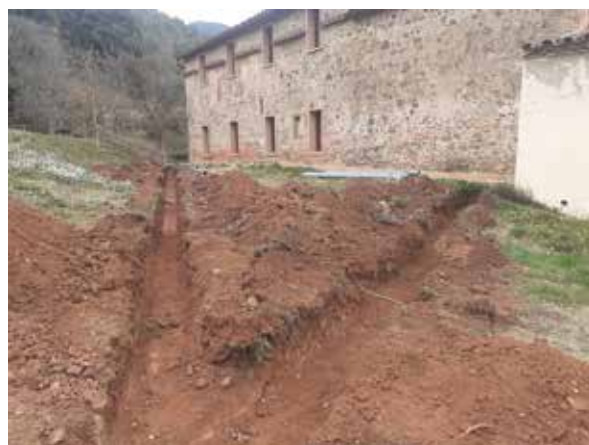
Recollida de pluvials i construcció de dipòsits d'acumulació de la Rectoria de Vallcàrquera. Font: Arxiu XPN
