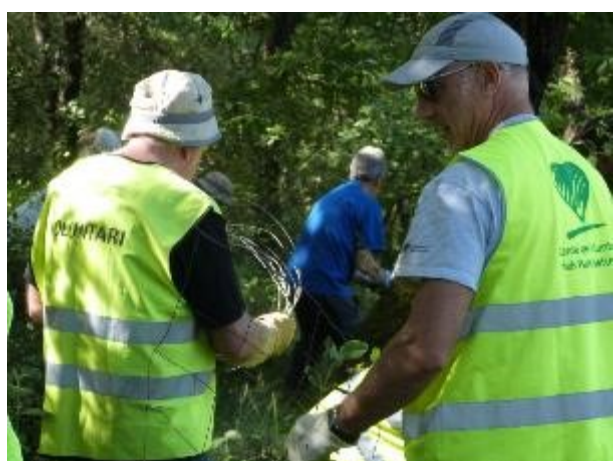
6. Desmantellament de tancats obsolets a la zona del llac. Parc del castell de Montesquiu
