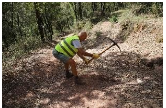
6. Arranjament de les carboneres de la ruta de les carboneres. Espai Natural de les Guilleries-Savassona
