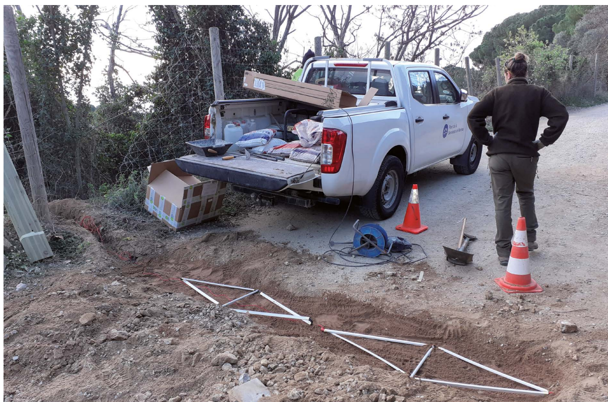
Instal·lació del nou ecocomptador a l'accés a Sant Jeroni de la Murtra. Font: Arxiu XPN
