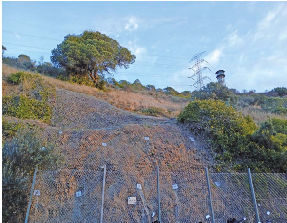
Incorporació d'una malla de triple torsió. Font: Arxiu XPN
