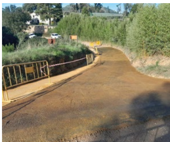
Obres de millora camí de Sant Bartomeu. Font: Arxiu XPN
