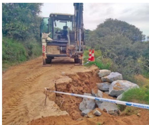
Reparació esvoranc camí Vallromanes - Coll de Clau. Font: Arxiu XPN
