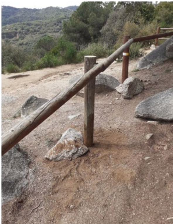
Reparació barana seguretat Roca de la Granota. Font: Arxiu XPN
