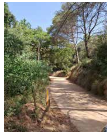
Reparació d'aforadors. Font: Arxiu XPN
