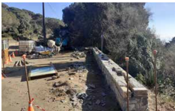
Construcció del mur de protecció. Font: Arxiu XPN
