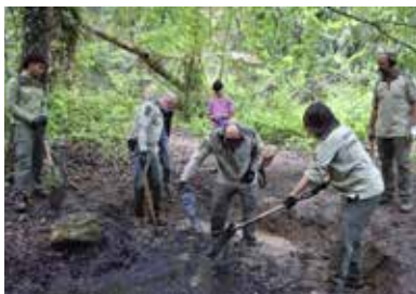
Guardes del Parc excavant el sòl per crear la bassa. Font: Arxiu XPN
