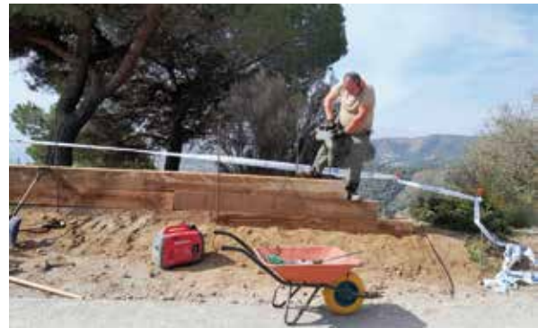
Arranjament del muret de contenció al mirador de la Cornisa. Font: Arxiu XPN
