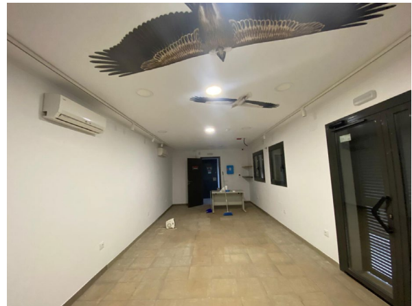
Obres de redistribució de l'interior del Centre d'Informació de Vilanova de Sau. Font: Arxiu XPN
