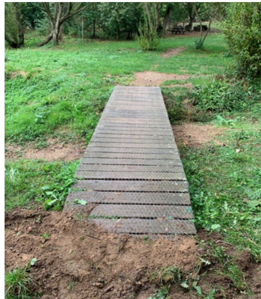
Treballs de millora de les passeres de l'àrea d'esplai de la Font Trobada. Font: Arxiu XPN
