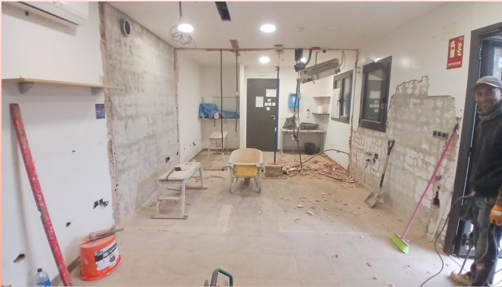
Obres CI Vilanova de Sau
