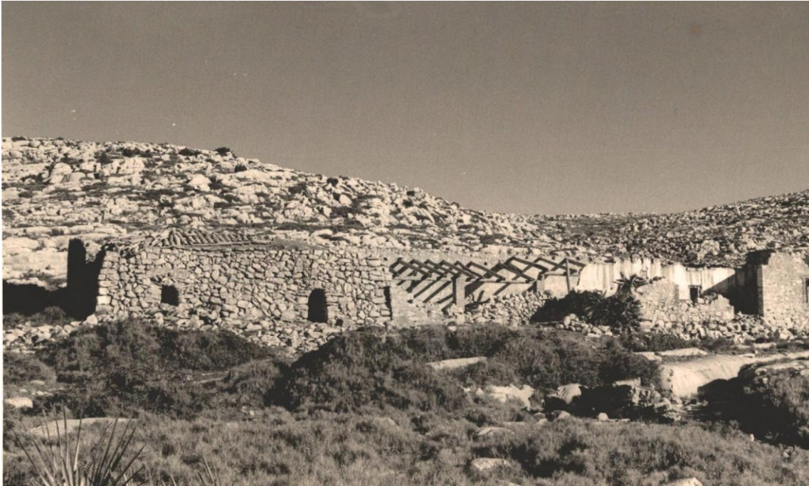
Barraques bessones del corral de Campgràs (VCV, Begues, 1968).
