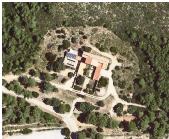
Imatge aèria del perímetre de prevenció d'incendis de La Pleta, Oficina del Parc del Garraf. Font: ICGC
