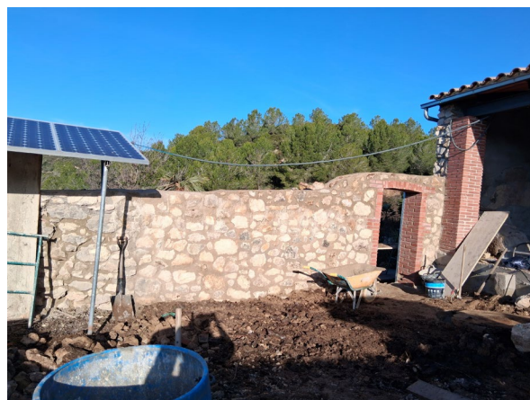
Reparació del mur del corral de Can Vendrell. Font: Arxiu XPN
