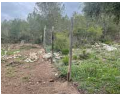
Reparació del corral de Can Vendrell. Font: Arxiu XPN
