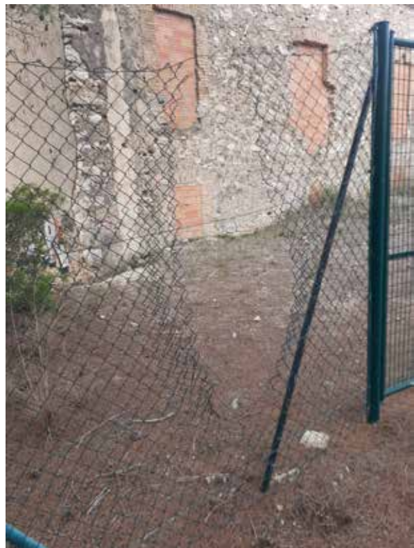
Reparació del tancat de Jafre. Font: Arxiu XPN
