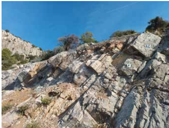
Estabilització del talús. Font: Arxiu XPN
