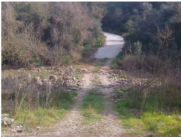
Camí de Xoriguera abans de les obres. Font: Arxiu XPN
