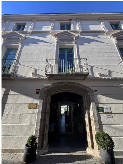
Foto 19. Entrada a l'edifici
