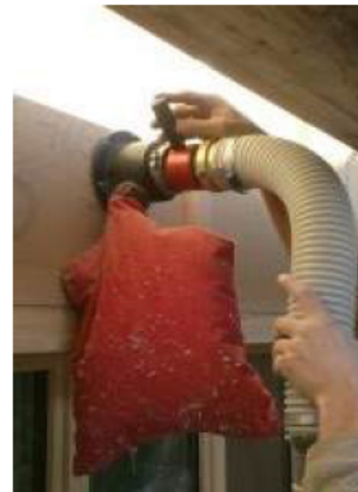
Ilustración 4: Relleno de cámaras (sistema Isofloc)
