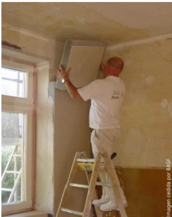
Ilustración 2: Aislamiento por el interior
