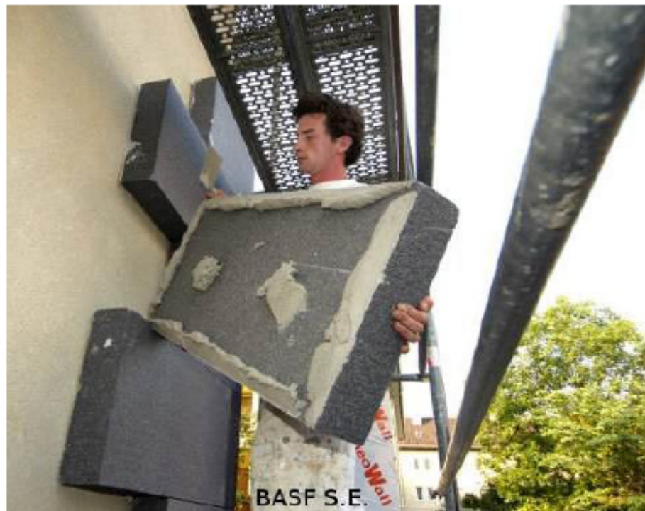
Ilustración 3: Aislamiento por el exterior
