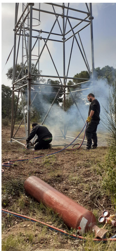
Detall de la torre de guaita del Fangar, que l'any 2020 es va quedar sense la part de l'habitable perquè va caure amb el temporal Gloria. Font: Arxiu XPN
