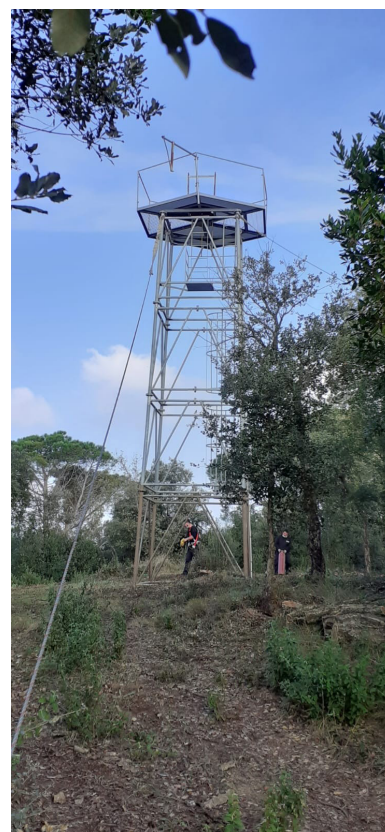
Treballs de retirada de l'estructura de l'antiga torre del Fangar. Font: Arxiu XPN
