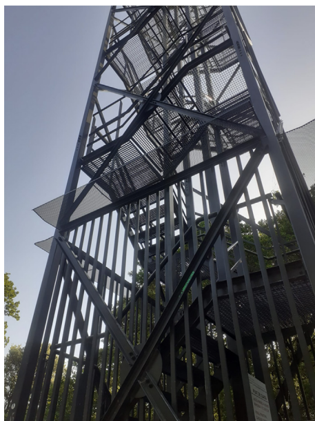
Detall de la visera a la part baixa de la torre. Font: Arxiu XPN
