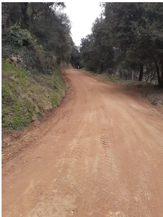
Arranjament de la pista Tordera-Calella a la zona del Montnegre Font: Arxiu XPN
