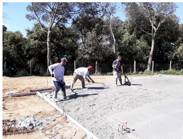
Treballs de solera de cobert de Can Bosc. Font: Arxiu XPN
