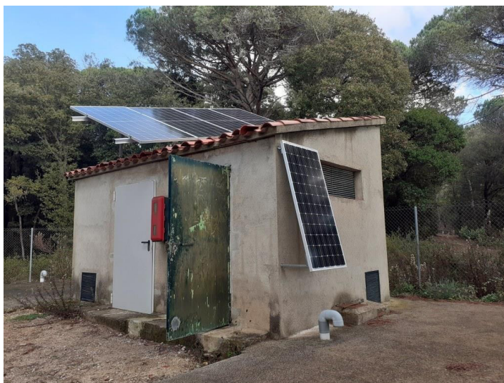
Instal·lació de noves plaques solars pel funcionament del nou clorador de l'àrea d'esplai del Corredor. Font: Arxiu XPN
