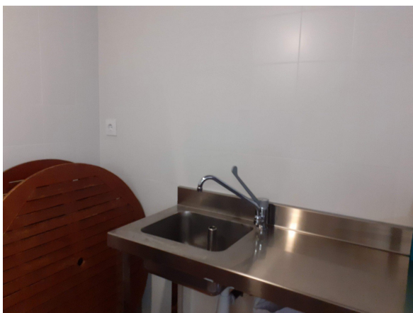
Pica nova adaptada a les condicions de la cuina. Font: Arxiu XPN
