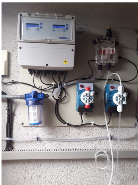
Nou sistema de cloració de l'àrea d'esplai del Corredor. Font: Arxiu XPN
