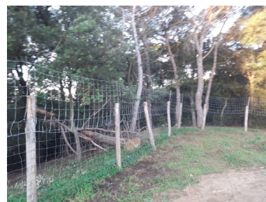
Reparació del tancat del voltant del cobert de Can Bosc. Font: Arxiu XPN
