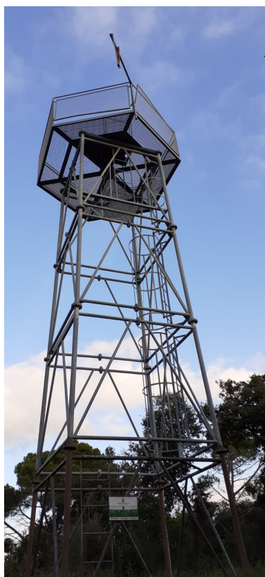
Treballs de desmantellament de la torre. Font: Arxiu XPN
