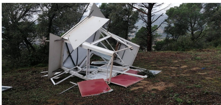
Part de l'habitable de la torre que va caure. Font: Arxiu XPN
