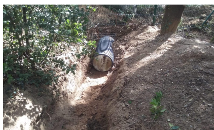
Col·locació de tubs per a la canalització de l'aigua al Campament juvenil El Solell. Foto: Arxiu XPN
