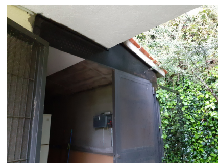
Millora dels tancaments de la sala de màquines del campament juvenil El Solell. Foto: Arxiu XPN
