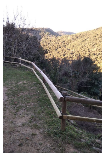
Substitució de la barana d'Hortsavinyà. Foto: Arxiu XPN
