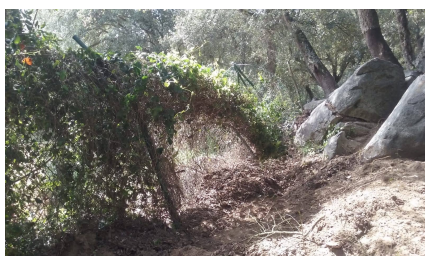
Reparació del tancament del Campament juvenil El Solell. Foto: Arxiu XPN
