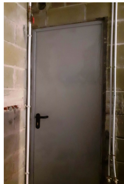
Nova porta d'accés a la sala de bateries. Foto: Arxiu XPN
