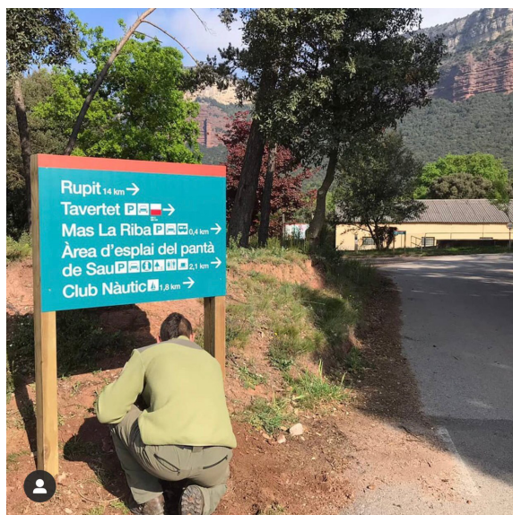
Treballs de manteniment: instal·lació de senyalització. Font: Arxiu XPN
