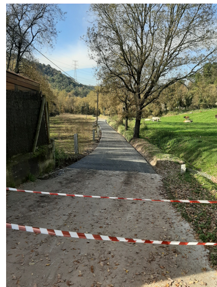
Obres al camí del Compòsit (Tavèrnoles). Foto: Arxiu XPN
