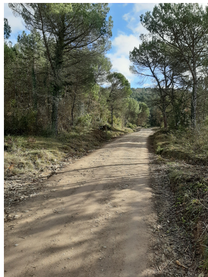
Realització de la secció de servei al camí dels Munts (Tavèrnoles)
