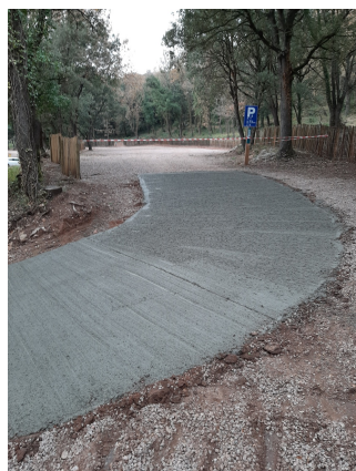
Formigonat de la rampa d'accés a l'aparcament. Foto: Arxiu XPN
