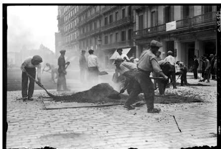
Treballadors duent a terme les obres d'asfaltat del tram baix de la Rambla de Catalunya, 1928. Ricart i Baguer, Narcís. Narcís Ricart i Baguer [CAT AGDB 65757]
