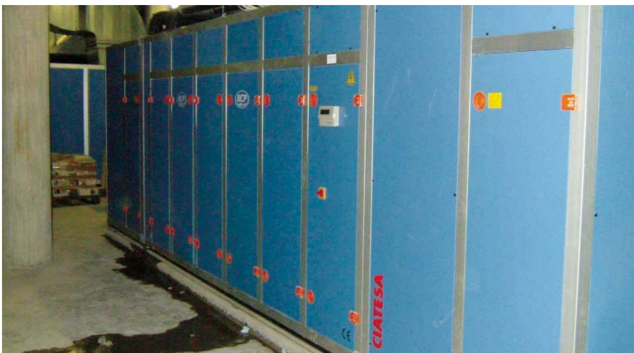
Figura 12. Bomba de calor deshumectadora
