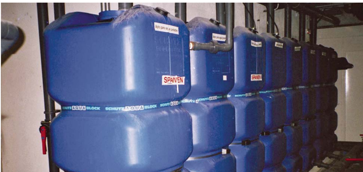
Imatge 3.2. Exemple de vas de compensació
