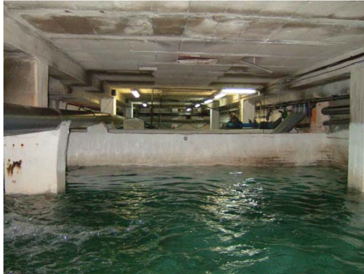
Els vasos de compensació oberts poden crear problemes de corrosió en les sales tècniques
