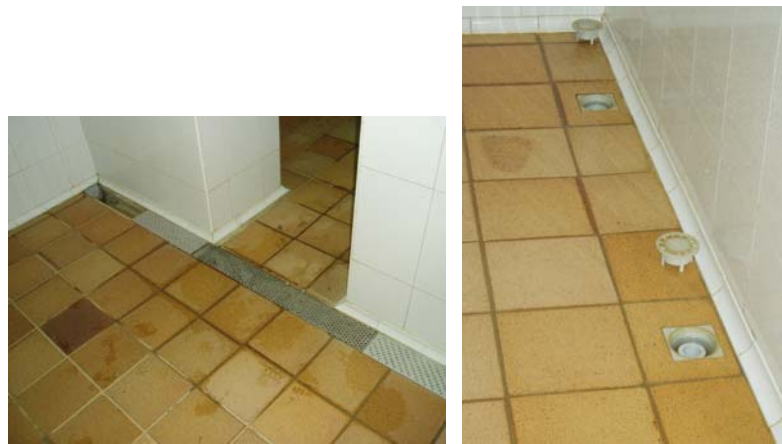
Supervisió visual de correcte estat i col·locació de les tapes dels desaigües
