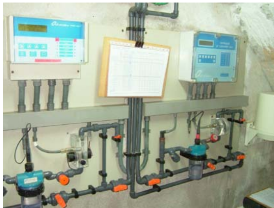
Control dels paràmetres de qualitat de l'aigua
