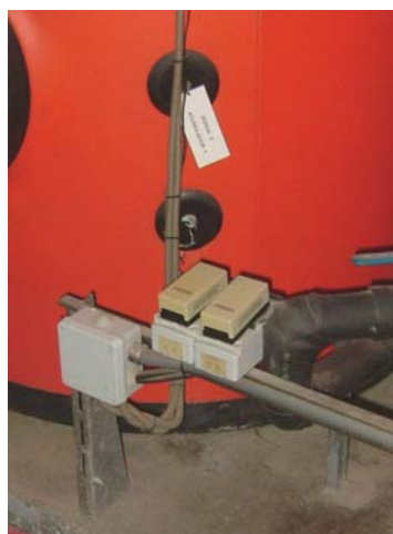
Protecció per corrents impreses mitjançant 1 o 2 ànodes de Titani
