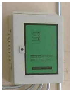
Protecció per corrents impreses un filat anòdic de Titani
