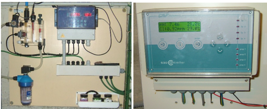
Lectures dels valors de monitoratge del ph i clor lliure dels autòmats
