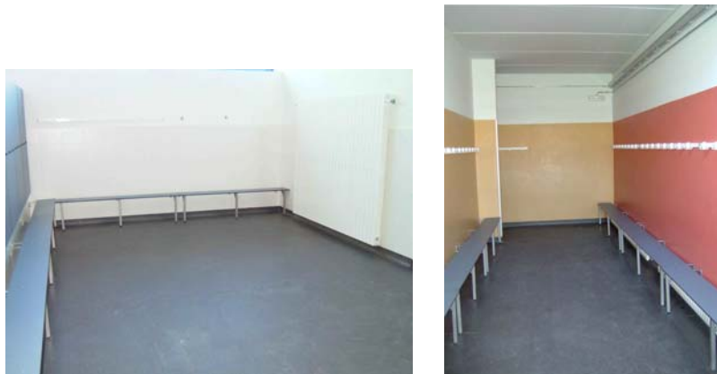
Supervisió visual de l'estat revestiments, paviments, bancs, penjadors
