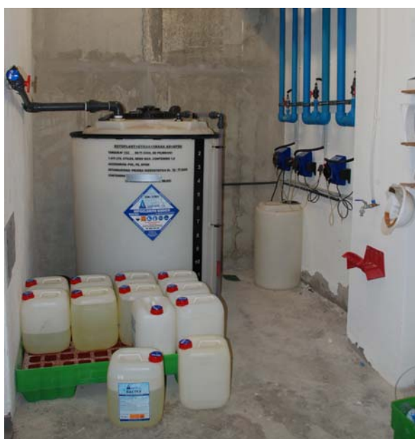
Sala específica d'emmagatzematge i dosificació de desinfectant
