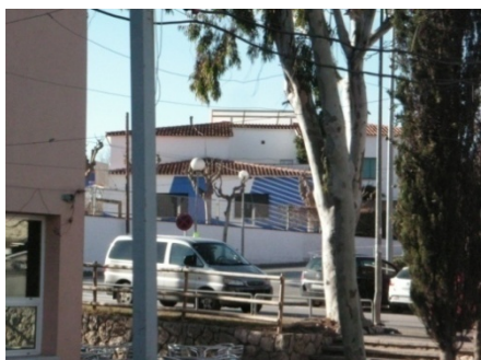
Estat actual façana
