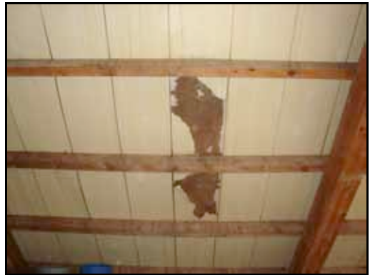
Estat de la coberta
