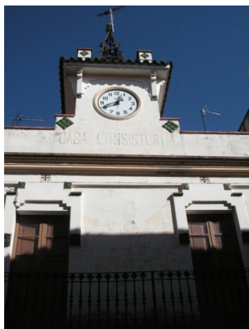
Estat actual façana
